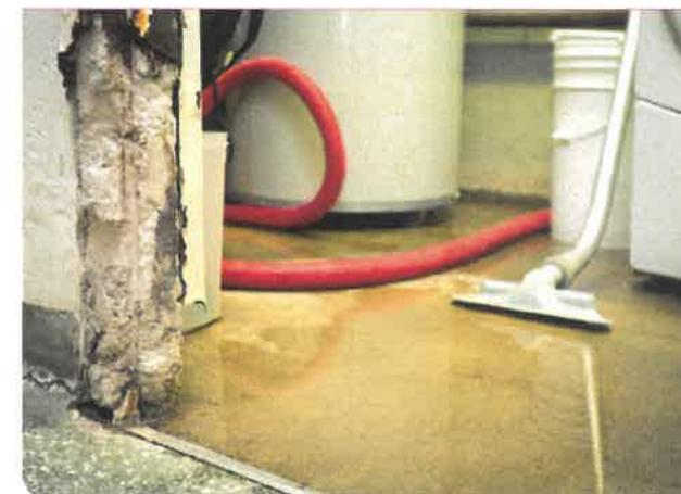
Regenwasser gehört nicht in den Schmutzwasserkanal, denn dort füllt es die Leitungen. Deswegen wird dieses Regenwasser auch als Fremdwasser bezeichnet. Dieses Fremdwasser belastet unsere Kläranlagen und die Kosten für die unnötige Spezialbehandlung gehen zu Lasten der Allgemeinheit. Das Fremdwasser verschärft zudem die oben beschriebene Hochwasserproblematik: In Gebäuden mit fehlender Rückstausicherung kann es zu nassen Kellern und so zu Ärger in der Nachbarschaft führen.
